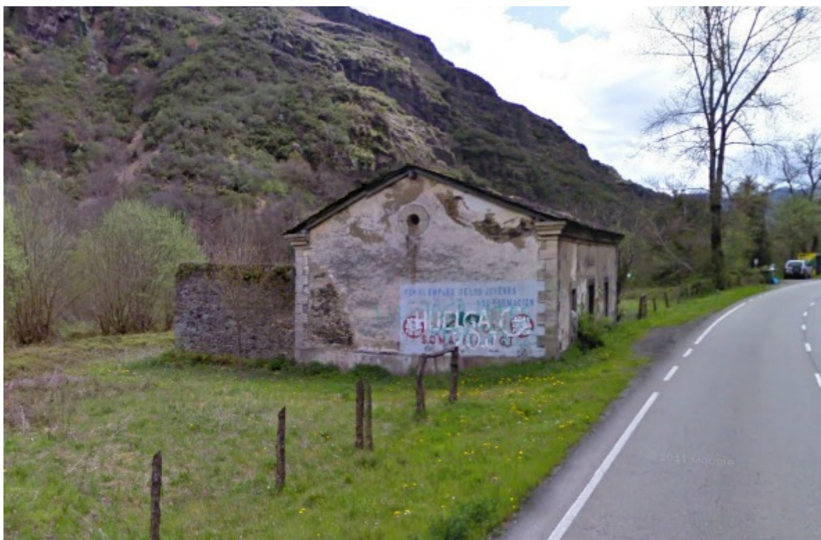
Fachada del edificio en dirección a Ventanueva
