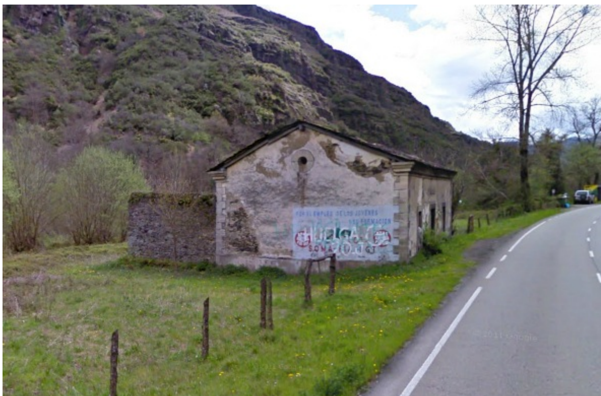
Fachada del edificio en dirección a Ventanueva
