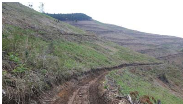
Ilustración 3. Estado de las infraestructuras
